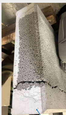
Lärmschutzteil aus Textilbeton
